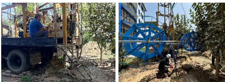
第1デモサイト（ドゥシャンベ）でのクローズドループ用熱交換井の掘削（左）とU型チューブの埋設（右）
