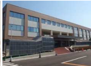
(医病) 基幹・環境整備 (屋外環境整備)
