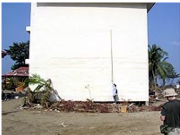
カオラックでは深いところで7mも浸水した
