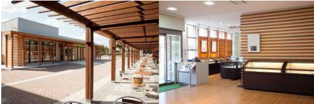
インフォメーションセンター外観および展示室
