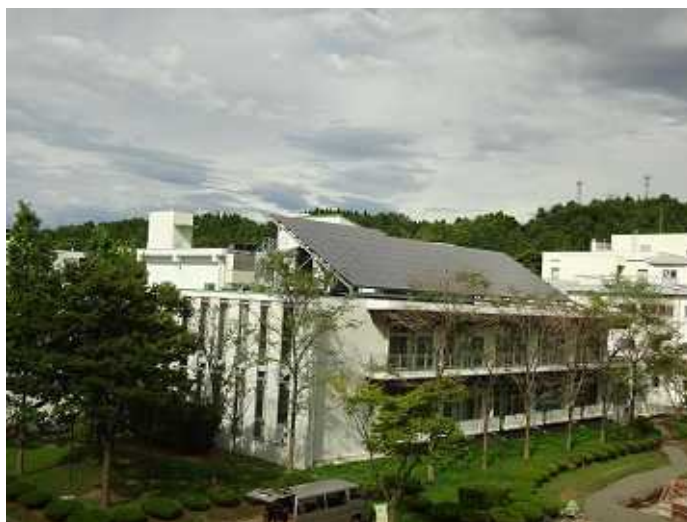
視察箇所（附属図書館屋上太陽光発電パネル）
