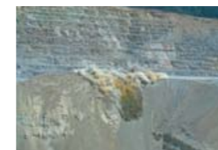
写真1 発破直後の様子
